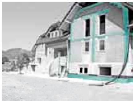
Izolacija toplotnih mostov potresnih vezi in preklad s FIBRANxps ETICS
