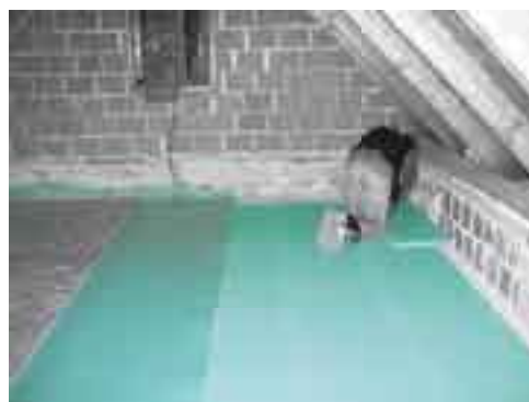
Suhomontažni pod podstrešja Toplotna izolacija FIBRANxps 300-I in FIBRANxpe kot izolacija udarnega zvoka
