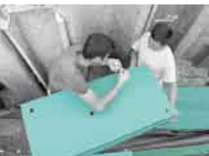
Lepljenje FIBRANxps 300-L na hidroizolacijsko membrano s FIBRANstick lepilnimi blazinicami.
