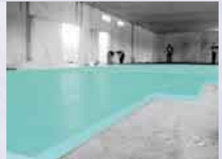
Toplotna izolacija poda skladiščnega objekta s FIBRANxps 300-L
