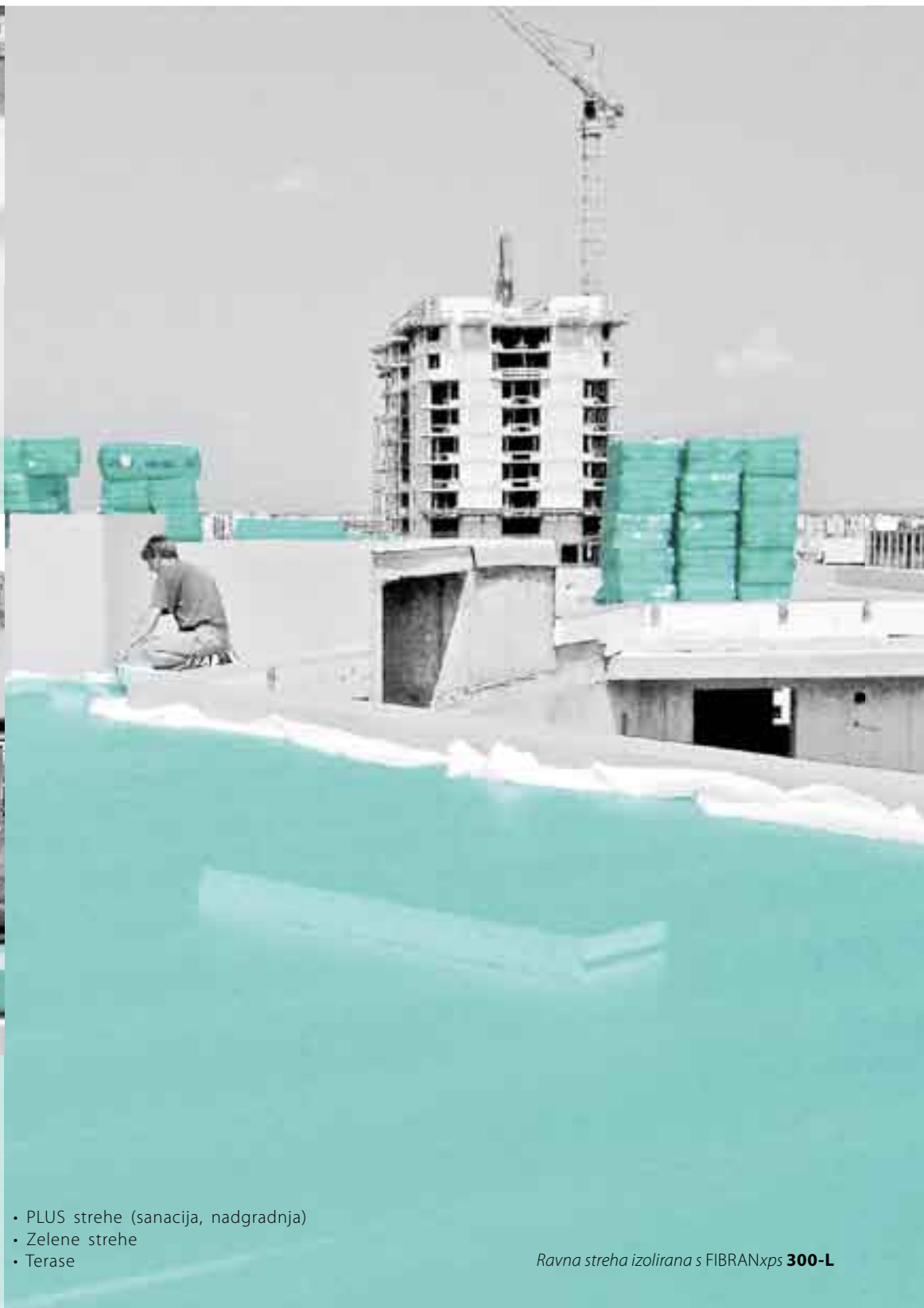
Vrt na terasi (princip obrnjene strehe) - FIBRANxps 300-L debeline 200 mm
