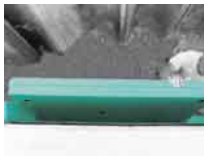
Lepljenje FIBRANxps 300-L na hidroizolacijsko membrano s FIBRANstick lepilnimi blazinicami.
