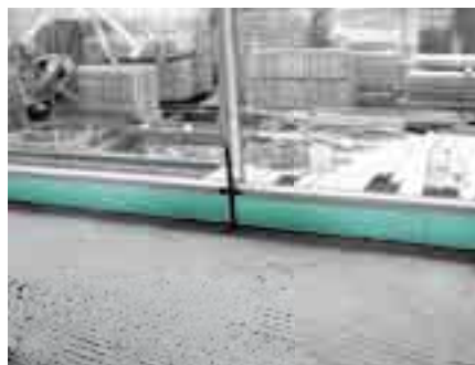
Reševanje toplotnih mostov na špaletah
