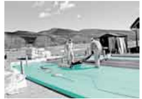
Toplotna zaščita temeljne plošče nizkoenergijske hiše s FIBRANxps 400-L
