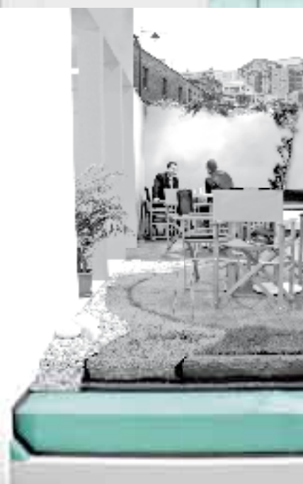
Vrt na terasi (princip obrnjene strehe) - FIBRANxps 300-L debeline 200 mm
