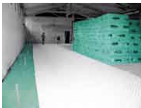
Toplotna izolacija FIBRANxps 300-I pod talnim ogrevanjem
