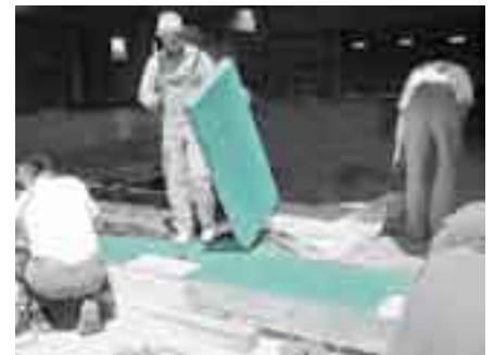
Toplotna izolacija izjemno obremenjenega poda. FIBRANxps 500-L
