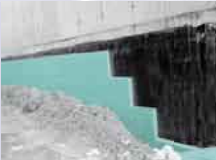
FIBRANxps 300-L mehanska zaščita hidroizolacije in toplotna zaščita kletnih prostorov hkrati
