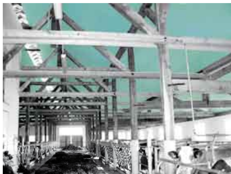
Vidna toplotna izolacija FIBRANxps MAESTRO ščiti prostor pred pregrevanjem poleti in ohlajevanjem pozimi
