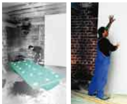
Notranja izolacija v kombinaciji z mavčno kartonsko ploščo. FIBRANxps FABRIC
